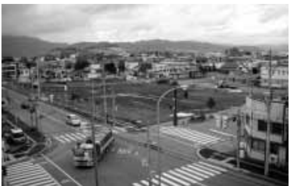
「フラノ・マルシェ」の建設が始まる旧協会病院跡地全景
