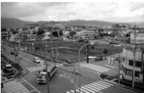
「フラノ・マルシェ」の建設が始まる旧協会病院跡地全景
