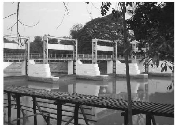
ミャンマーの頭首工
