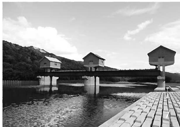
左岸側本体工事と門扉の設置が完了
