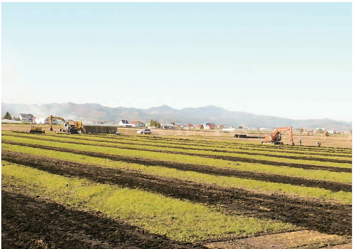
国営農地再編整備事業宇文工区（東5線北6号）にて暗渠排水工事の施工状況（平成23年10月20日撮影）
