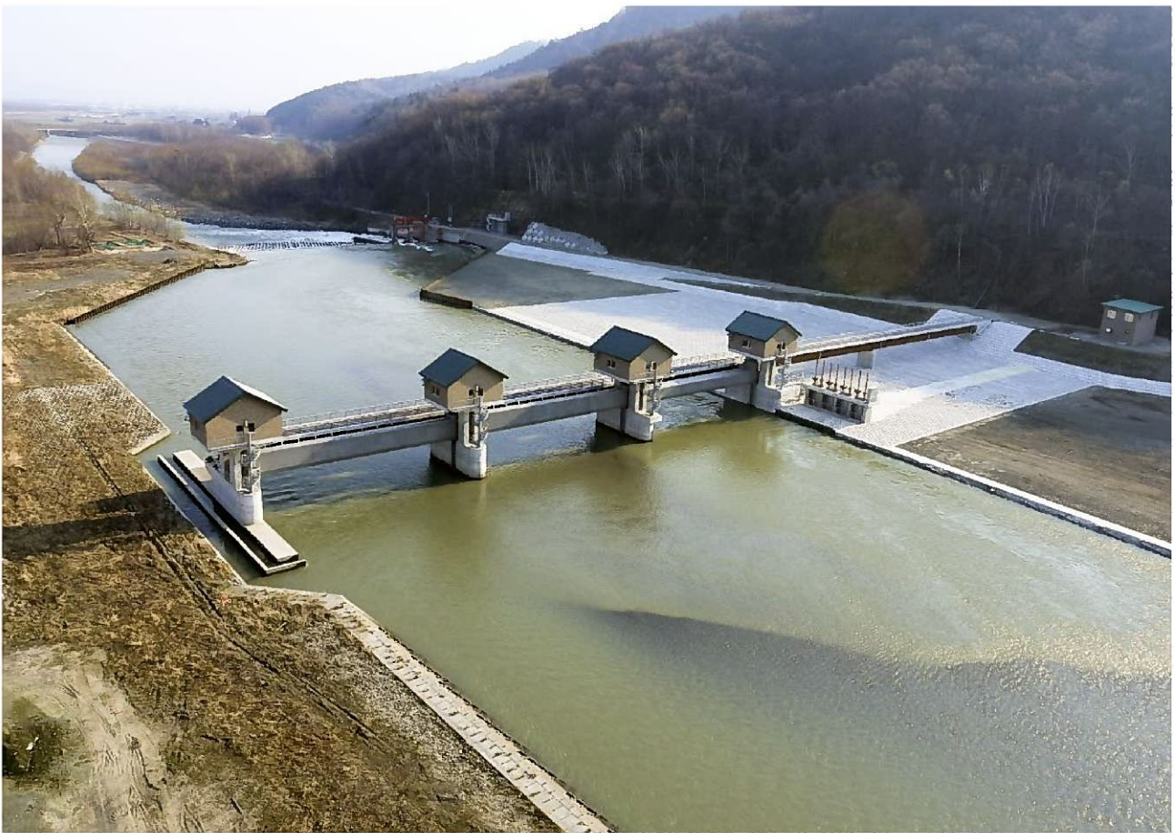
今年度より供用が開始された新空知川頭首工 (平成26年4月26日撮影)
