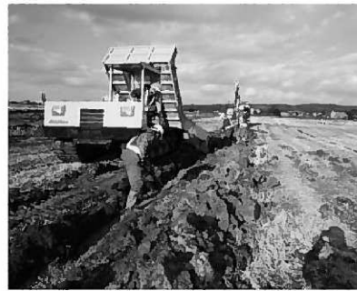
疎水材ピリ砂利投入状況 (東中南地区)
