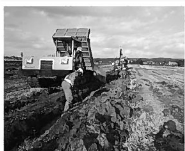
疎水材ビリ砂利投入状況 (東中南地区)
