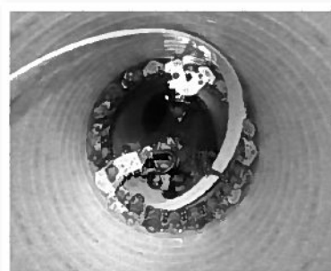
更正管自走製管状況 SPR 工法 (東幹線地区)
