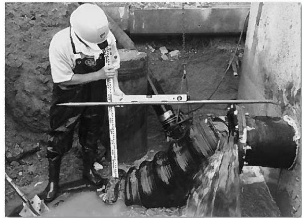
沈下量を測定している様子
