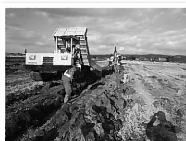
暗渠排水工疎水材ビリ砂利投入状況 (東中南地区)
