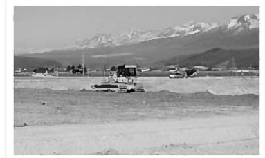
区画整理(富良野盆地地区)
