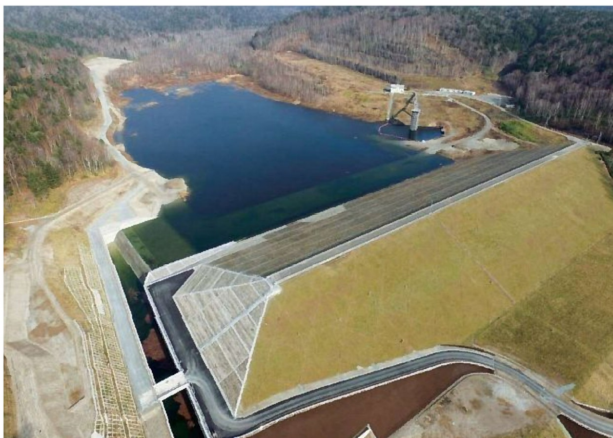
現在試験湛水を実施している東郷ダム（平成29年11月7日撮影）
