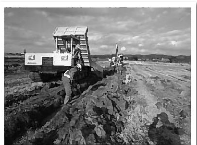
暗渠排水工疎水材ビリ砂利投入状況
