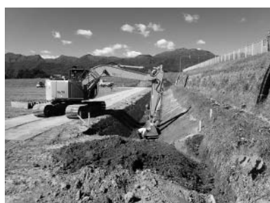
排水整備工事状況
