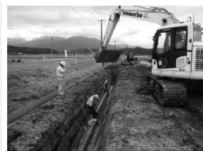
用水路管敷設状況
