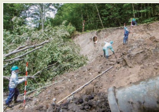
災害現場において被害状況調査を行う職員
