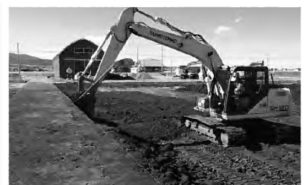
畦畔築立状況
