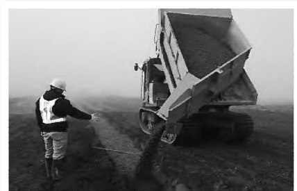
疎水材投入状況
