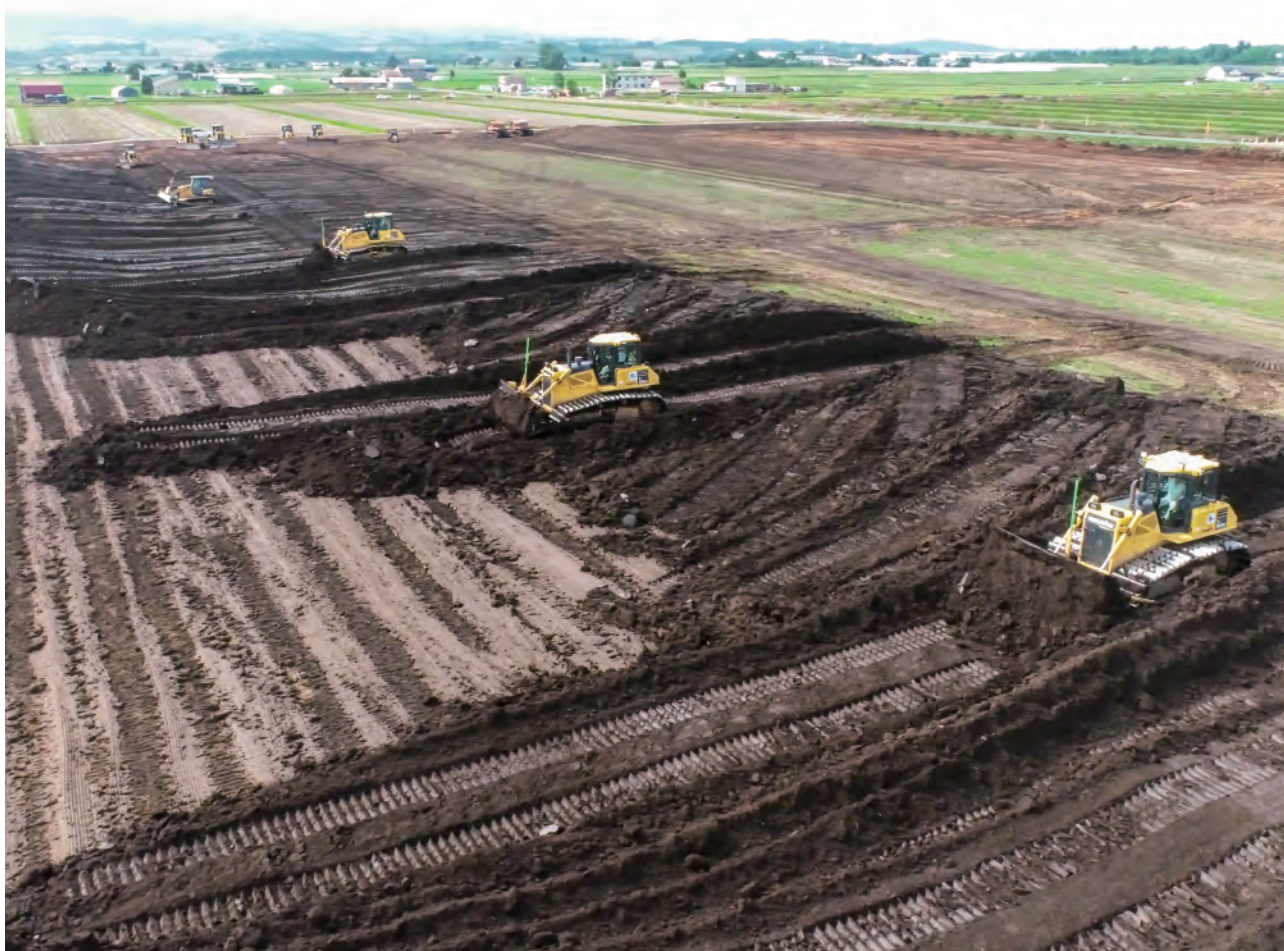
道営農地整備事業東中第1地区 表土均平施工状況
