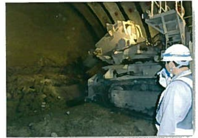
まさに掘削の瞬間！
