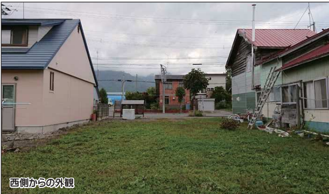
東側からの外観
