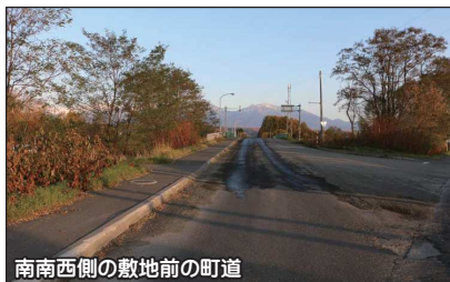
南南西側の敷地前の町道
